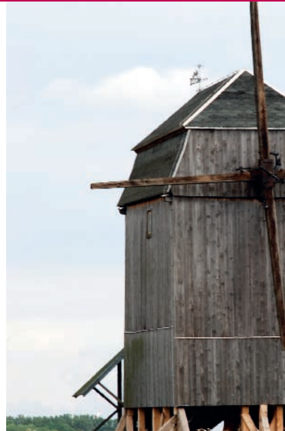
Seit Jahrhunderten wird die Kraft des Windes genutzt. Im Bild: die Bockwindmühle Tüngeda.
