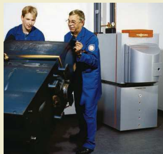
Moderne Technik und ein umweltfreundlicher Brennstoff: Austausch einer alten Heizungsanlage durch eine neue Erdgas-Brennwertheizung.
